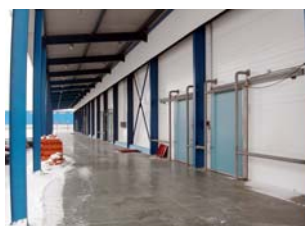
Холодильный комплекс 5000 т, ПУТИНА, Брянск
