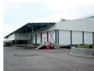
Холодильный комплекс 2500 т, ВИК, Владивосток
